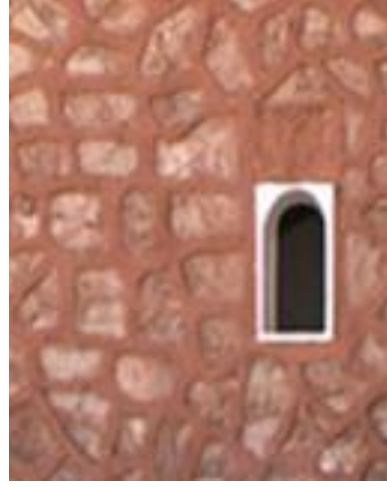
صورة 23: طريقة صقل الحجارة مع تركها بارزة
