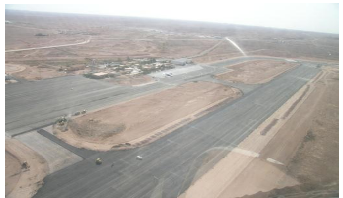
Figure III.05 : vue aérienne d'aéroport Ville de Ghardaïa
