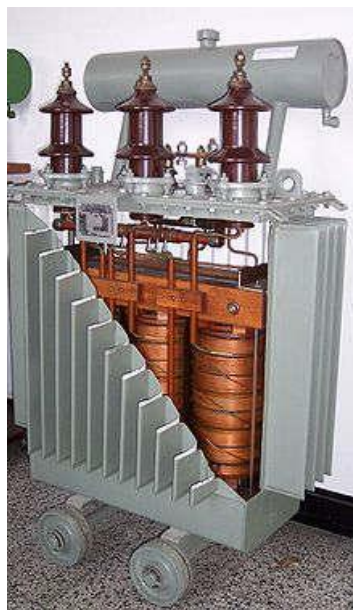
Figure I.2 Modèle d'un transformateur[3]
