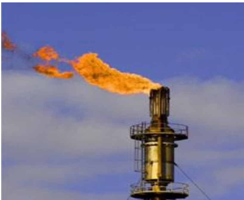
Figure02 : Torche de Gaz Hassi R'Mel. ; source : google image
