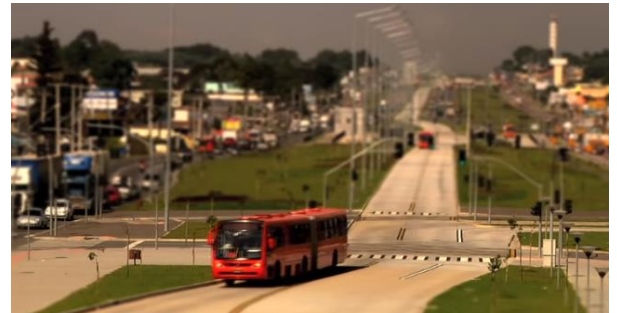
Figure61 : le site propre des bus ; source : google
