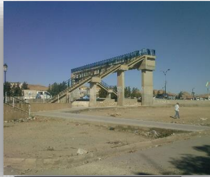
Figure45 : Passerelle ; Source : par auteur
