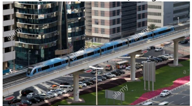
Figure74 : métro sur le viaduc
