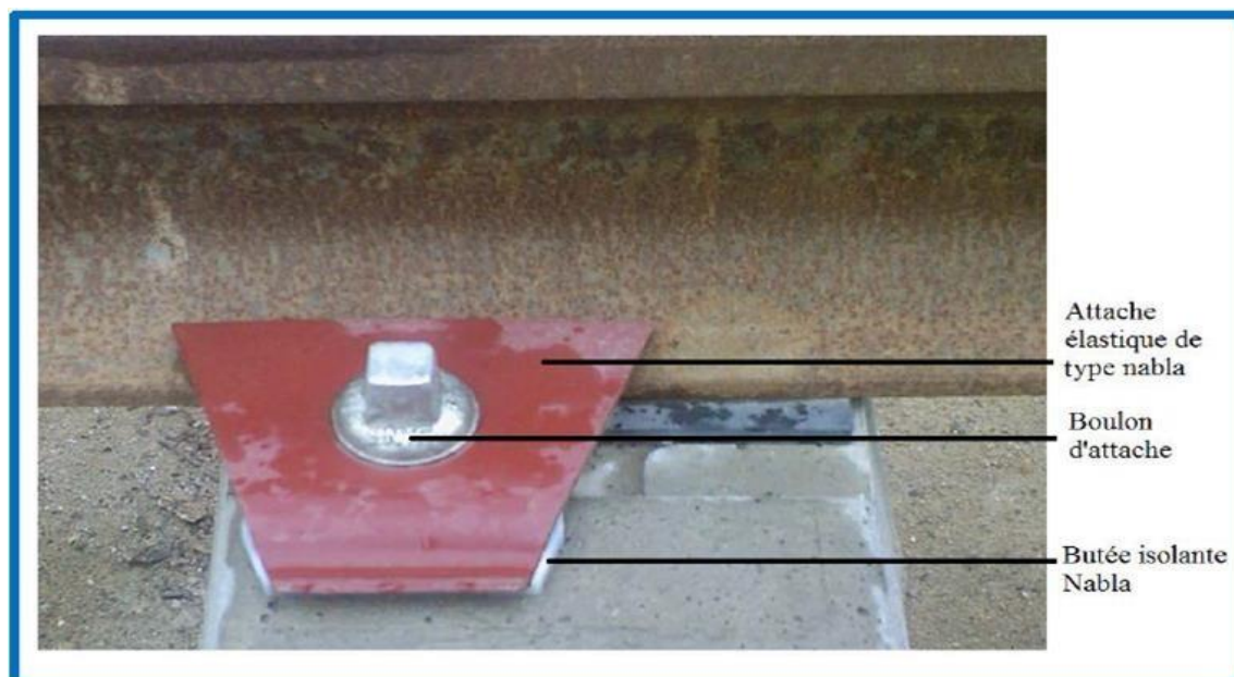
Figure VI.18 : Les éléments d'une attache de type Nabla.
