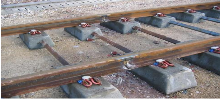
Figure VI. 7 : Photo d'une barre soudée
