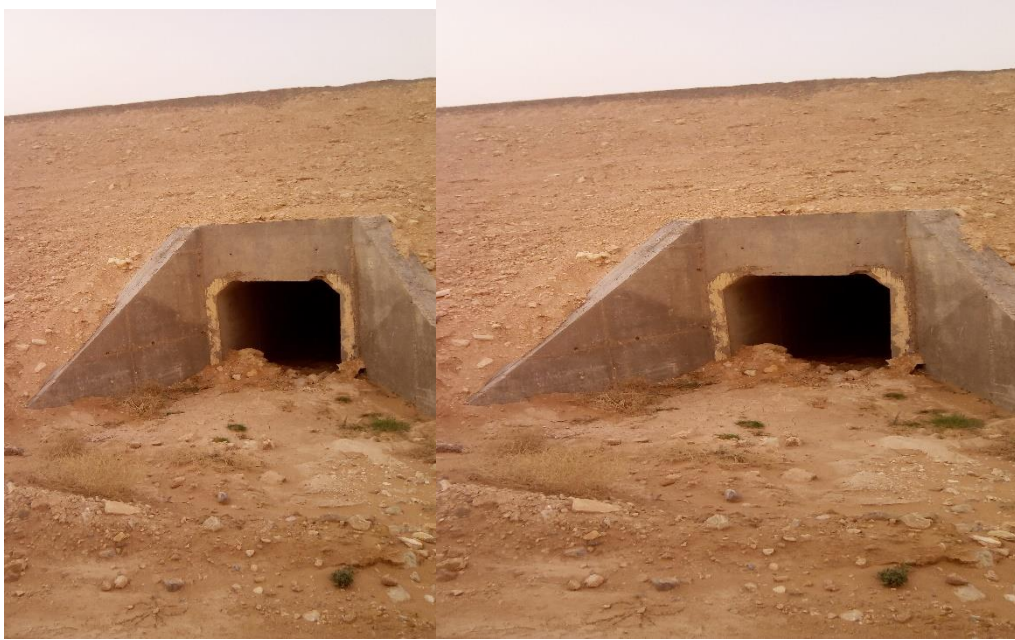
Figure VII. 3: Dalot sous remblai
