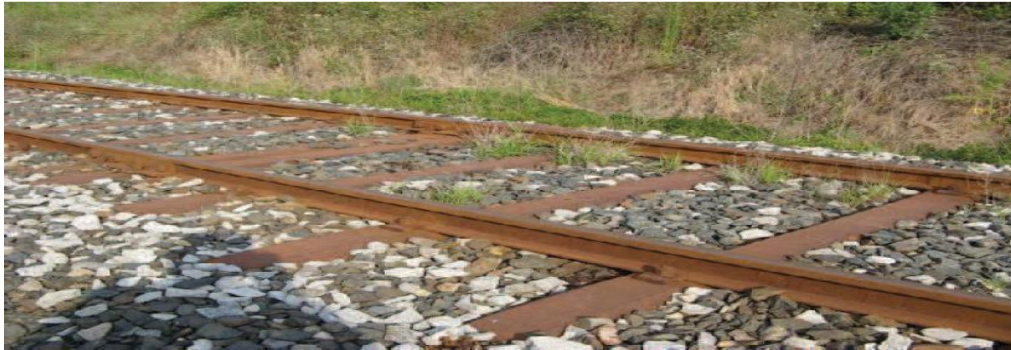
Figure VI.15 : Traverses métalliques
