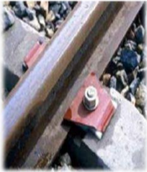
Figure VI.16 : Attache de type Nabla
