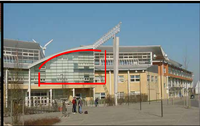
fig.07:façade SUD du lycée -source: www.paris-
