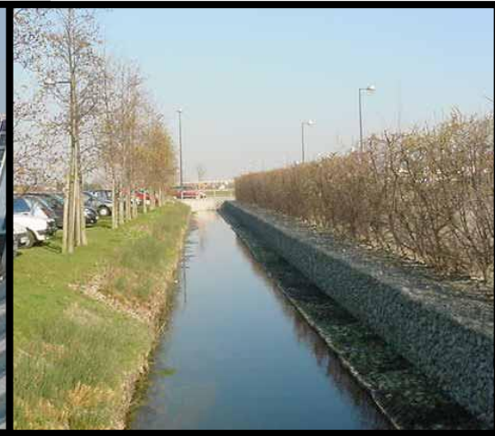
fig.13:les bassins d'eau dans le lycée- source: www.prog-ecologis.com
