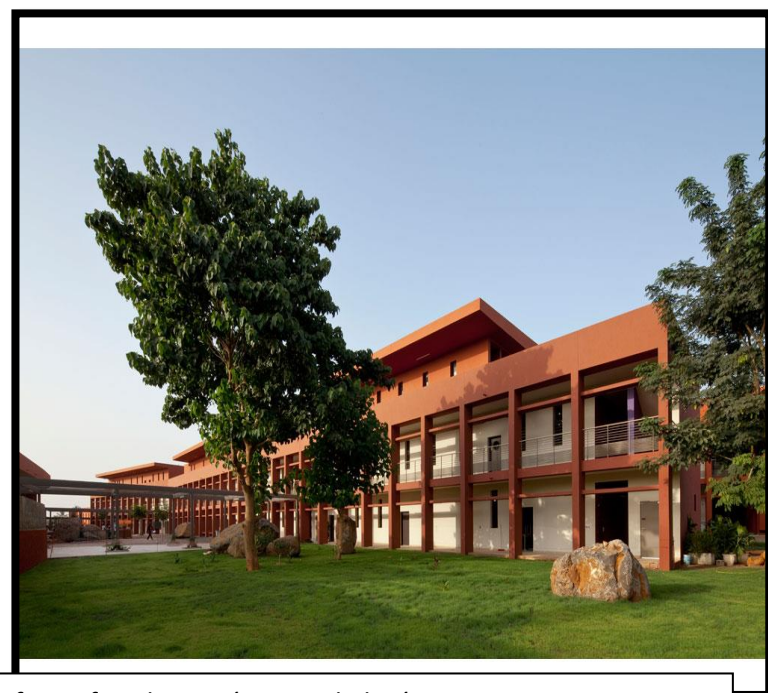
fig.33: façade postérieure du lycée- source:www.darchitectures.com
