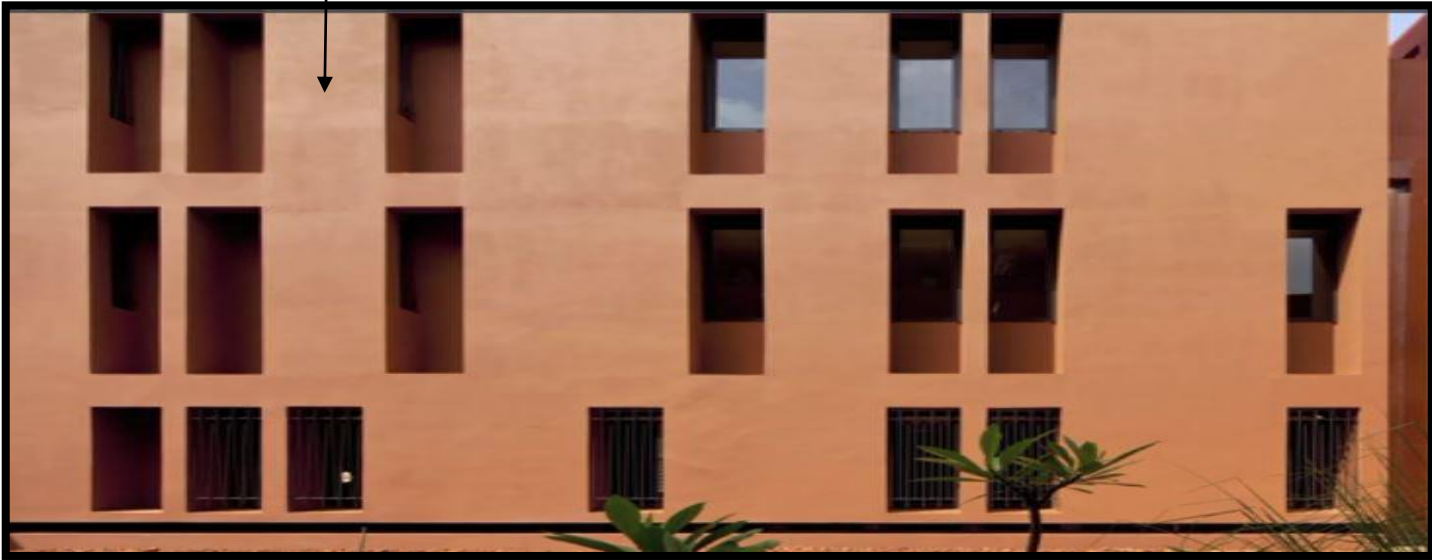
fig.36:le mur épaie du lycée -source: www.terreneuve.fr
