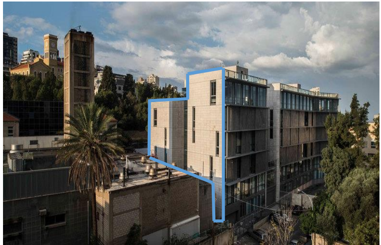
Fig I 29 : façade est ouest Source : fr.weatherspark.com.
