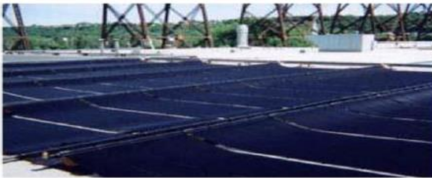
Figure I.10 : Capteurs plans sans vitrage [18].
