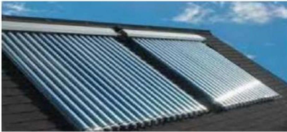
Figure I.12 : Capteur sous vide [20].
