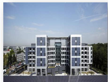
Photo06:Façade principale Source : http://www.green-office.fr
