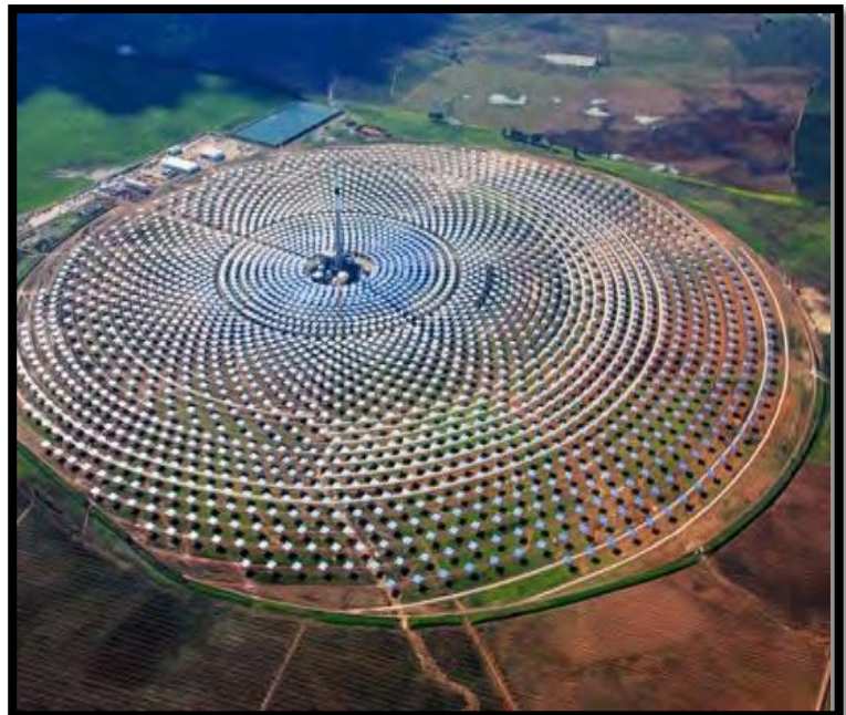
Photo 08 : énergie solaire (station shams) Source : http://www.utilities-me.com/article-1677-masdar-shams-1-will-launch-q3-2012 p visité 26/05/2016
