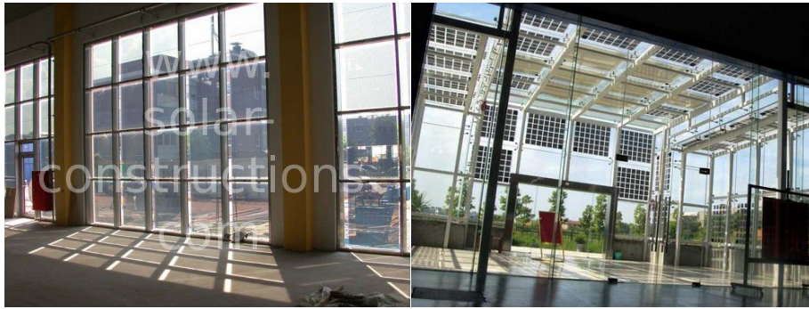
Figure 119 : Façade à vitrage photovoltaïque transparent source : (panneaux solaires transparentes)
