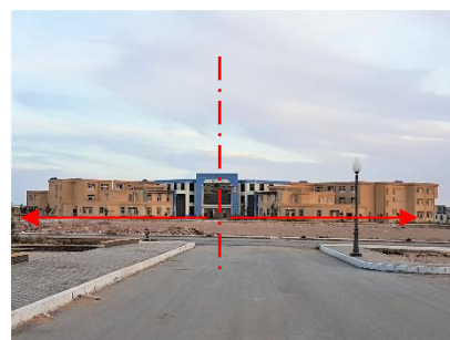
Figure 59 : Département de technologie R+2
