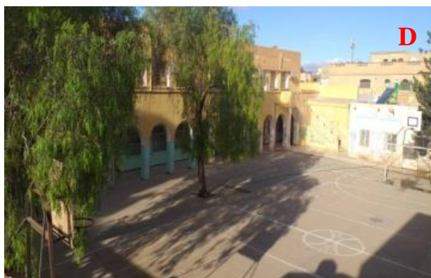
Figure III .32 (A.B.C.D) Des Vues Sur Les Interventions Maladroites Source auteur
