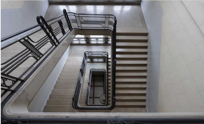
Figure I.15: Escalier central (vue de haut)
