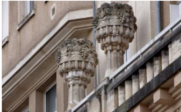
Figure I.14: Élévation sur la cour Charles III : détail de vases décoratifs au niveau de la galerie supérieure Source : https://www4.ac-nancy-metz.fr › lyc-cyffle
