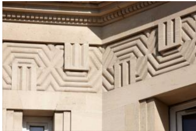
Figure I.13: Élévation sur la cour Alexandre : détail du décor du 1 er niveau
