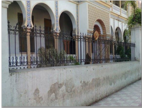
Détail de la clôture
