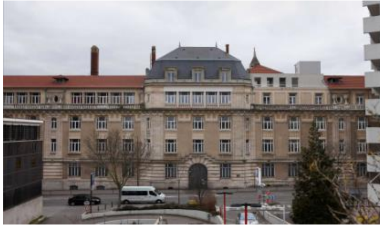
Figure I .11: Façade principale sur la rue Cyfflé : portail
