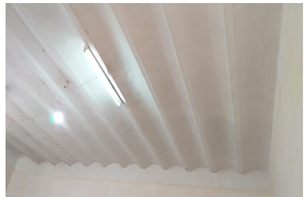
Figure III .34 Photo du plancher Source auteur
