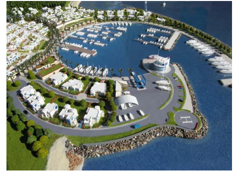
Figure n26: Vue sur le port Source : Archi-Mag
