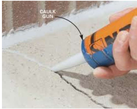
الشكل (13-1) الترميم بالحقن [26]
