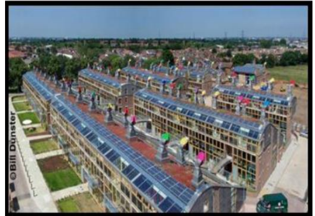
Figure I.14 : photo montre l'installation des cellules des panneaux Photovoltaïque
