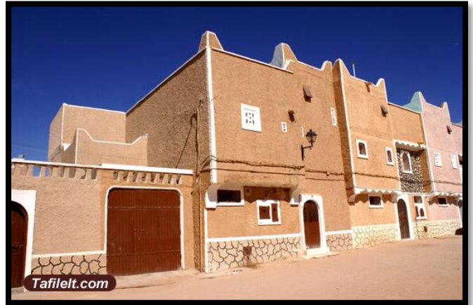
Figure 21 : photo présent traitement de façade, source : http://tafilelt.com/
