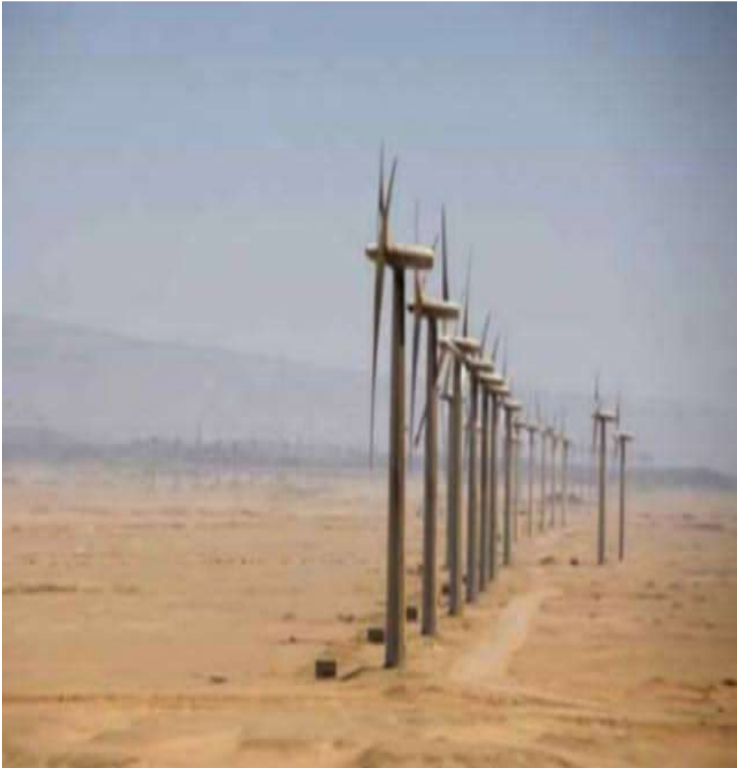
Figure 1.5. Ferme éolienne de 10 MW du site Kaberten.ADRAR2014
