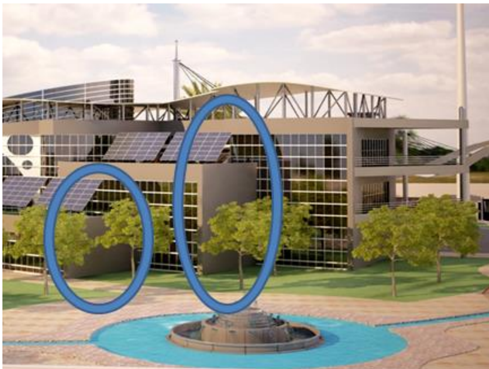
Figure 61 : la façade est du projet
