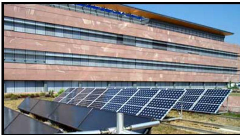
Figure 17 : les panneaux solaires au niveau de toiture du projet Source : ( www.constructiondurable.com )
