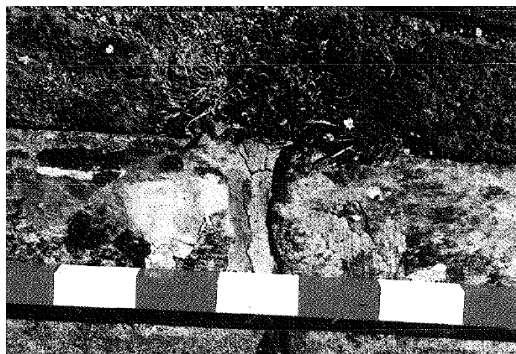
Figure II. 22 - Rejet de pompage dans une chaussée rigide
