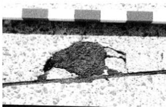
Figure II. 21 - Nid de poule dans une chaussée rigide
