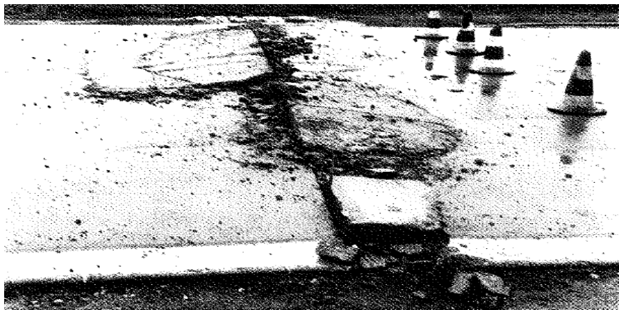
Figure II. 19 - Flambement d'une chaussée rigide
