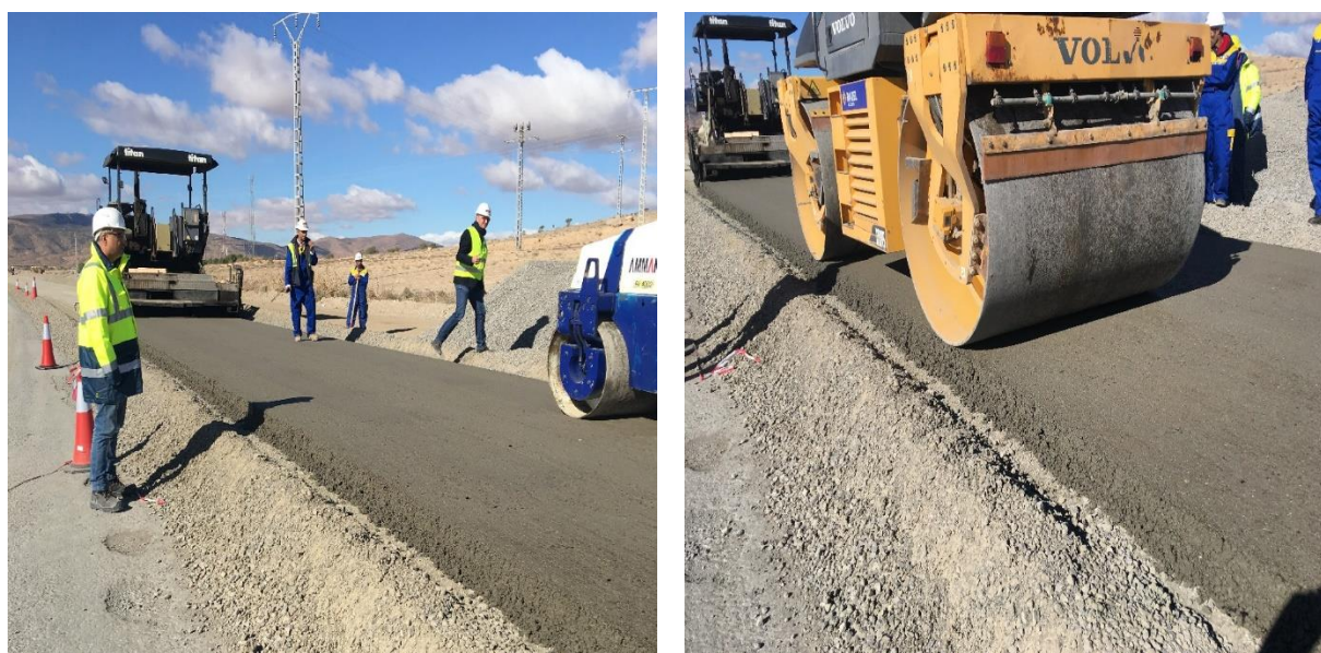
Figure IV. 8 - Mise en œuvre de BCR [28]
