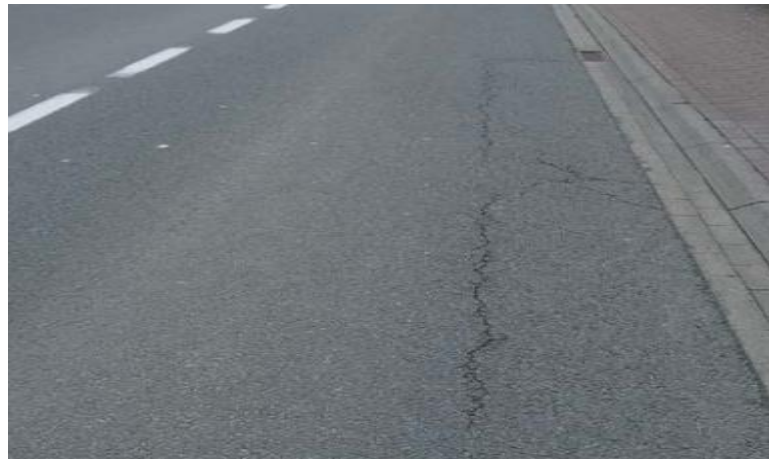
Figure II. 4 - Fissure longitudinale des rives
