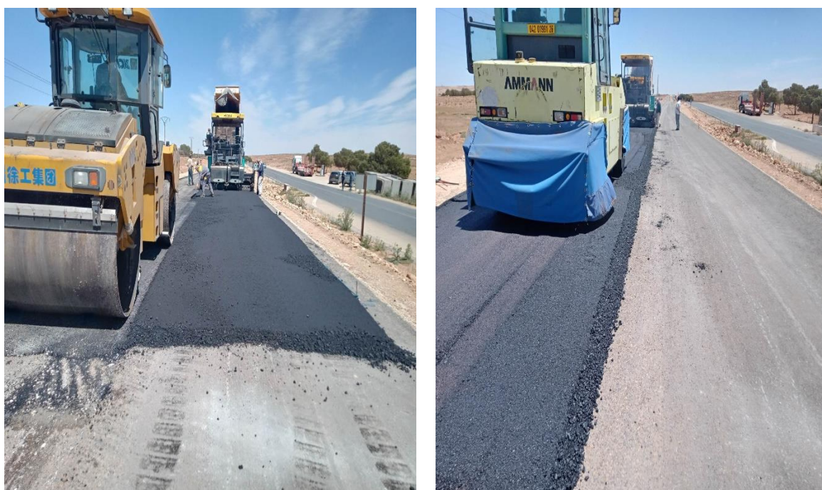
Figure IV.6 – Mise en œuvre de Béton bitumineux [27]
