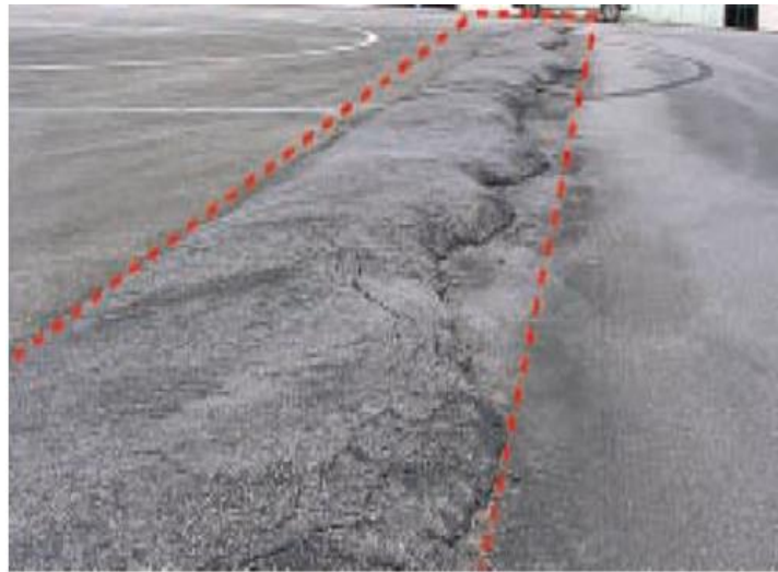
Figure II. 7 - Bourrelets longitudinaux
