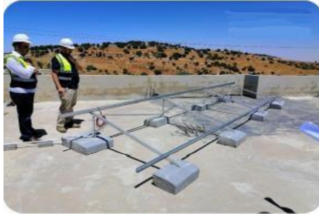
Figure IV. 2 : La structure est en aluminium ou en alliage d'aluminium.
