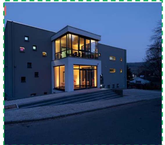
Fig II-7 l'immeuble de bureau LAMPENWELT
