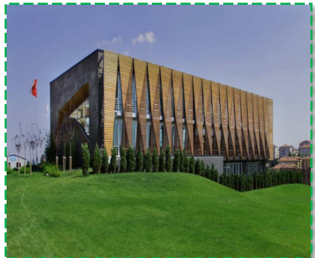
Fig II-18 l'immeuble de bureau à Istanbul
