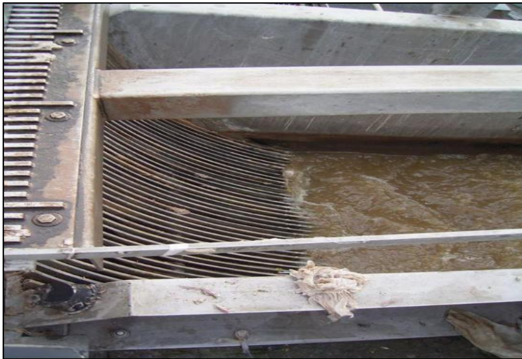
Figure II.2: Lamelles de dégrillage [29].
