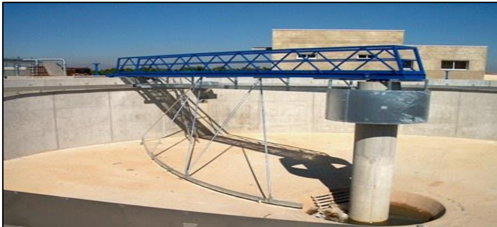
Figure II.5: Décanteur.
