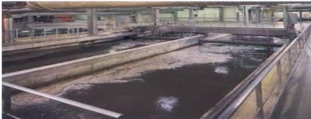
Figure II.3: Dessableur-dégraisseur rectangulaire [32].
