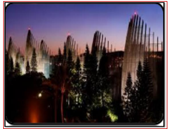
Figure 01 : Centre culturelle de TIJBAW Source : http://archdaily.com
