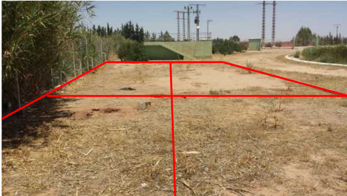
Figure. 27 : traçage de la forme des filtres
