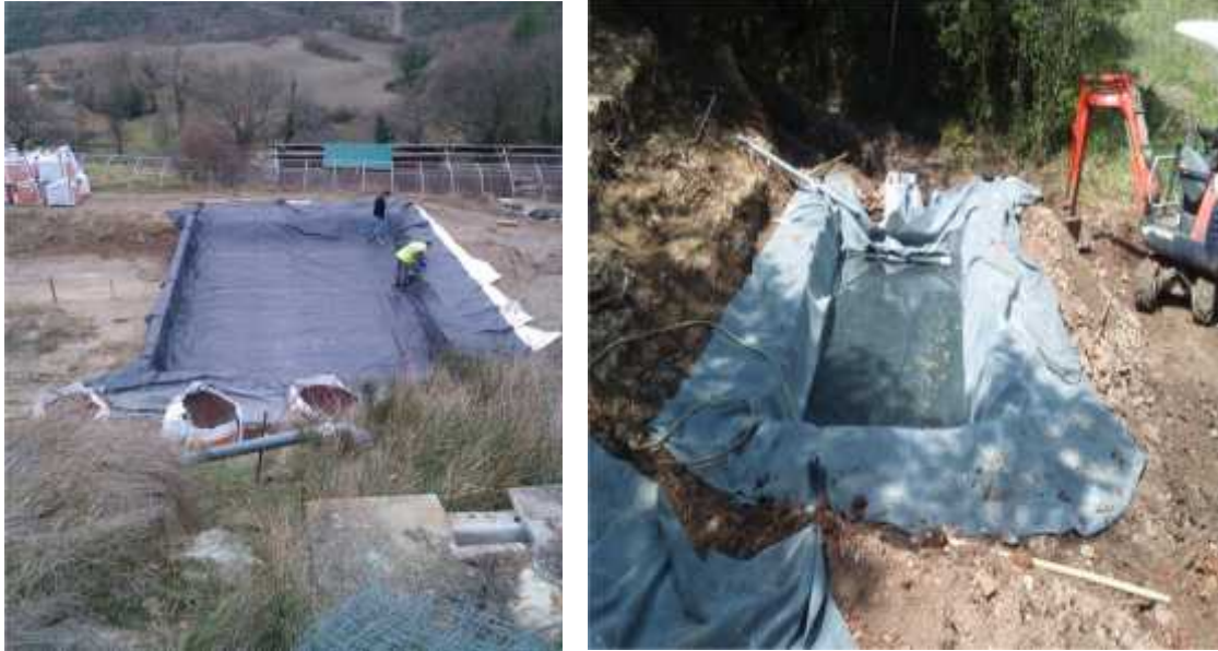
Figure. 28 : l'habillement du bassin par des géomembranes
