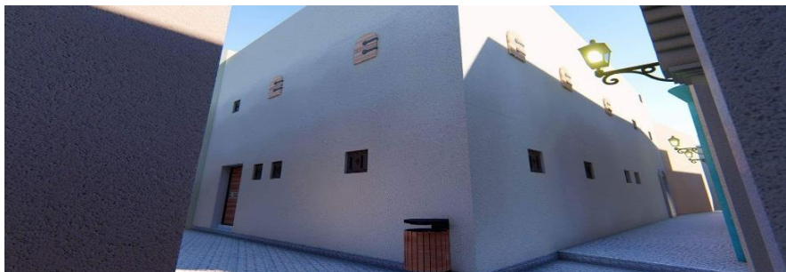
Figure 118: vue de texture extérieure de la maison .Elaborer par l'étudiante .
