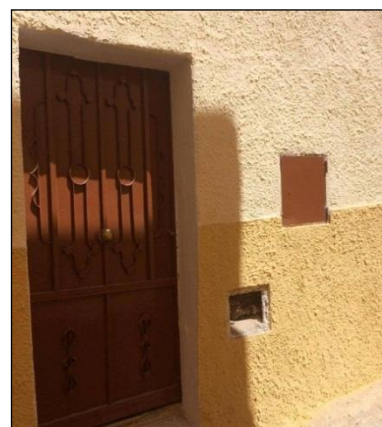
Fig.112 : Porte extérieure (Source : Auteurs)
