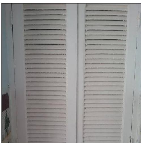
Fig.125 : Les fenêtres (Source : Prise par auteurs)
