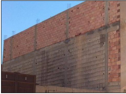
Fig.141: Mur en brique (Source : pris par auteurs)
