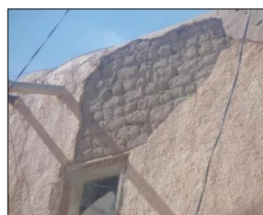
Fig.118 : Mur en adobe (Source : Prise par auteurs)
