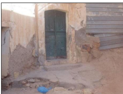
Fig.116 : Porte d'entrée (Source : Prise par auteurs)
