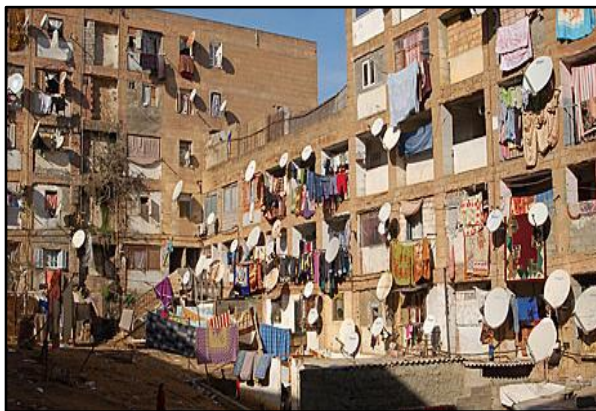
Fig.06 : Immeubles d'un quartier populaire - antennes paraboliques - Diar El Mahcoul, Alger. (Source : www.travel-images.com )
