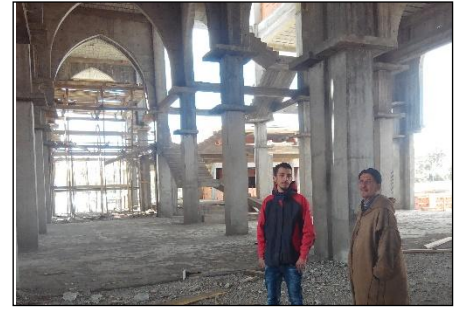
Fig.143: Structure poteaux-poutres (Source : pris par auteurs)
