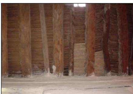
Fig.117 : planché roseaux (palmiers) (Source : Prise par auteurs)
