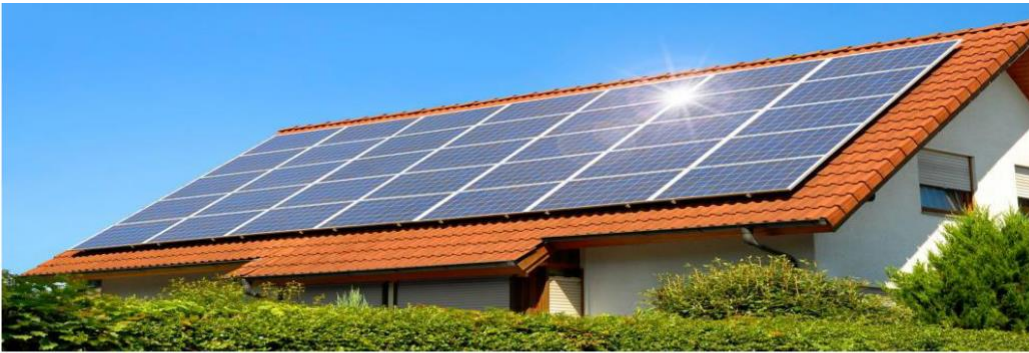
Figure IV-03 : représente des panneaux photovoltaïques pour capturer l'énergie solaire
