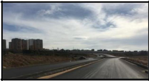
Figure II-48 : représente la voie secondaire au site (Source : prisé par l'auteur 17 novembre 2018,)
