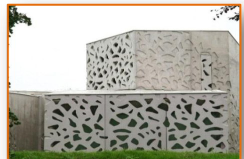
Figure 104: OUVRAGE EN BETON AUTO PLAÇANT SOURCE :( HTTP://ASSOHQE.ORG )
