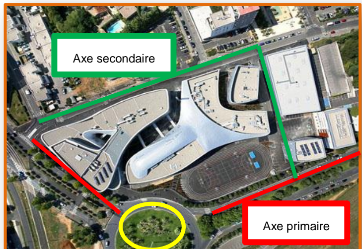
Figure 9: photo arienne de projet Source : (Google Earth)
