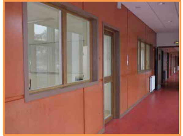
Figure 134 : Apport de lumière naturelle par second jour (Lycée Robert Schuman à Charenton Source : Traite d'Architecture et d'Urbanisme bioclimatiques
