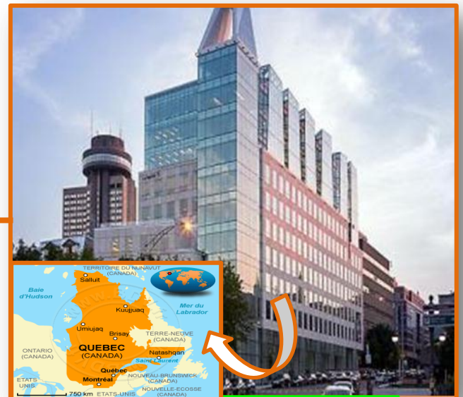
Figure 16: Siège social de La Capitale Source : (ecochantier.lacapitale.com)
