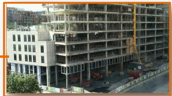
Figure 26 : le chantier de siège social de la capitale Source : (ecochantier.lacapitale.com)
