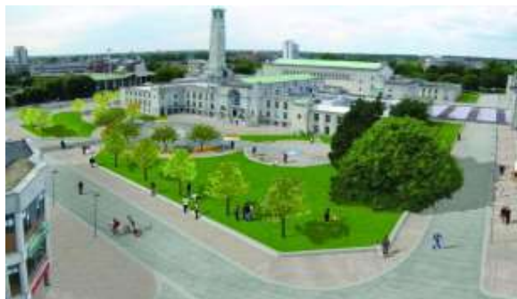
Figure 59 : aménagement vert de place public. Source: Google images
