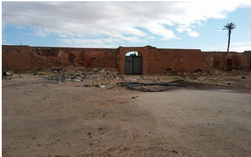
Fig. III.A. 22.Les remparts de caravansérail de sidi Makhloof
