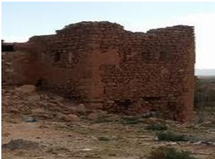
Fig. III.A.21.les tours de Caravansérail de Sidi Makhloof
