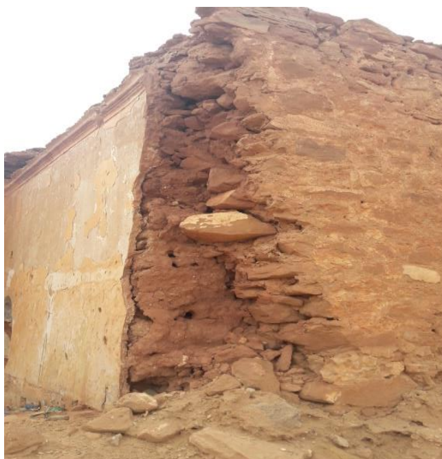
Fig. III.A.23. un mur de caravansérail de sidi Makhloof
