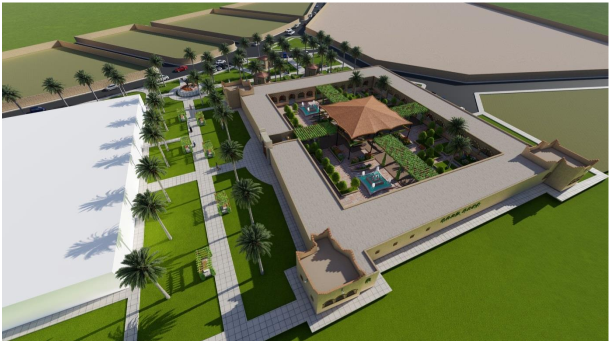
Fig. III.B.72. Vue générale sur le caravansérail
