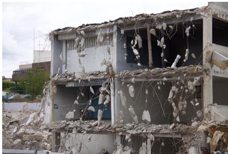
Figure 21 les travaux de démolition
