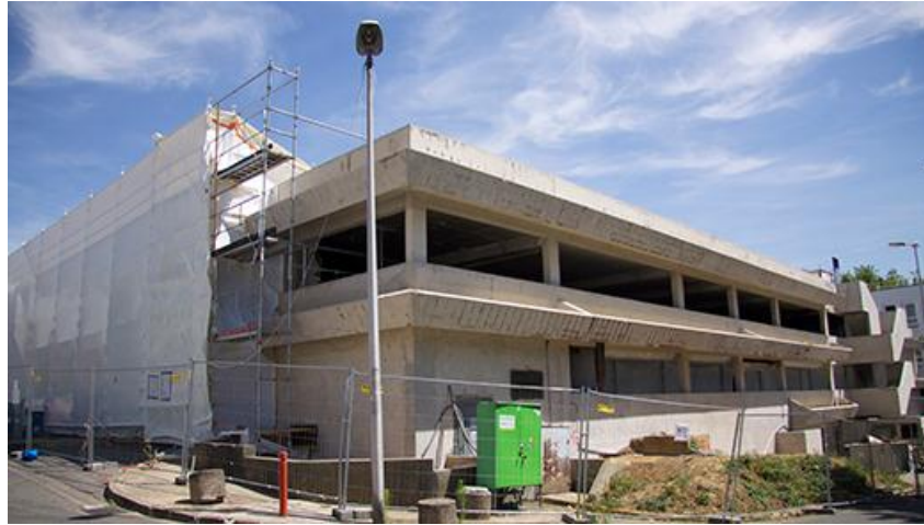
Figure 20 démolition du parking
