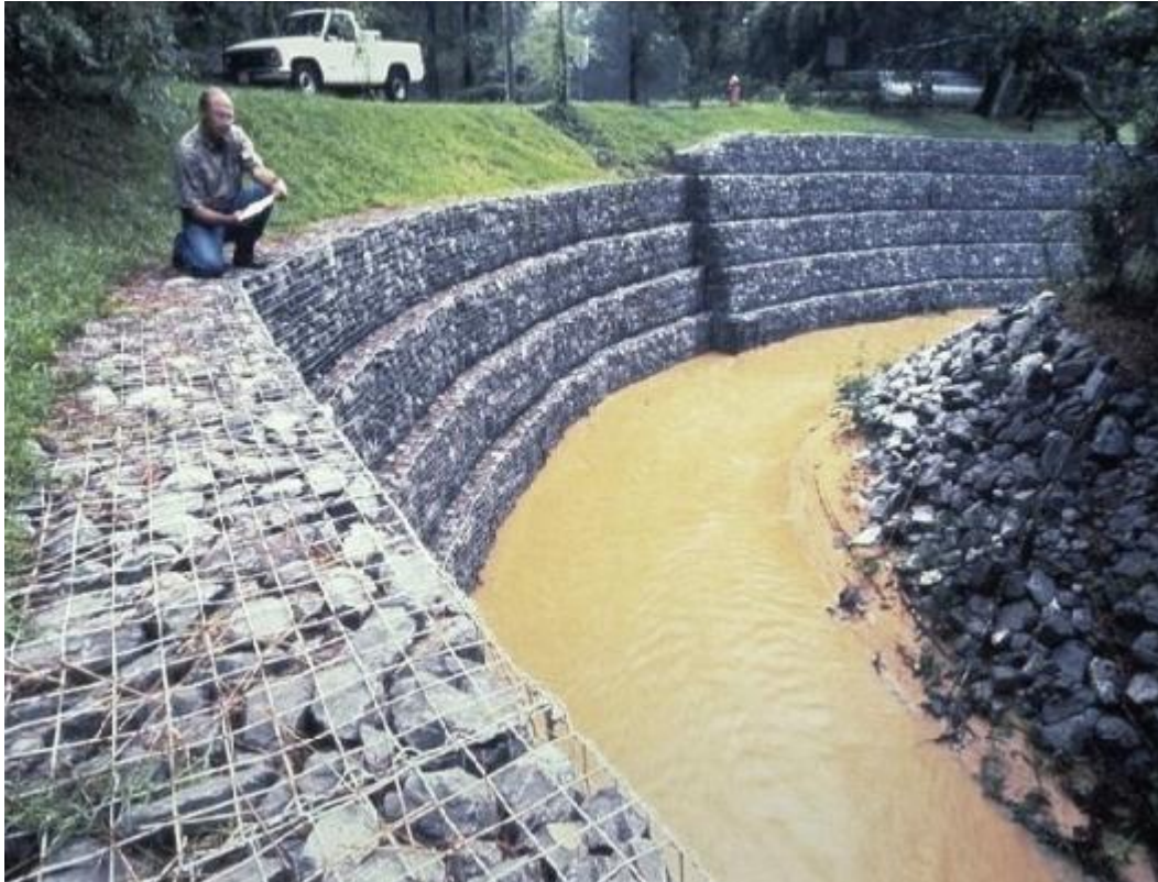
Figure 135:renforcement des berges d'eloued par les murs en gabion ,source https://www.google.dz/search?q=principe+des+seuils+en+gabion+controle+l%27eau&rlz=1C1SQJL_enDZ796DZ796&source=lnms&tbn=isch&sa=X&ved=0ahUKEwjzI-TCsOvbAhVH7RQKHdD9BKoQ_AUICigB&biw=1517&bih=73
