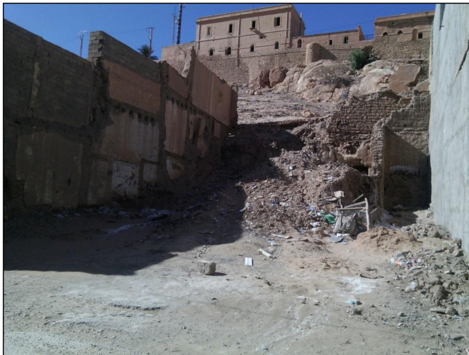
Figure 71: destruction des anciens construction, source : auteur
