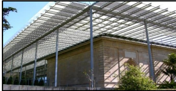
Figure 53 : intégration du panneau photovoltaïque (source : https://fr.wikiarquitectura.academie-des-sciences-de-californie )
