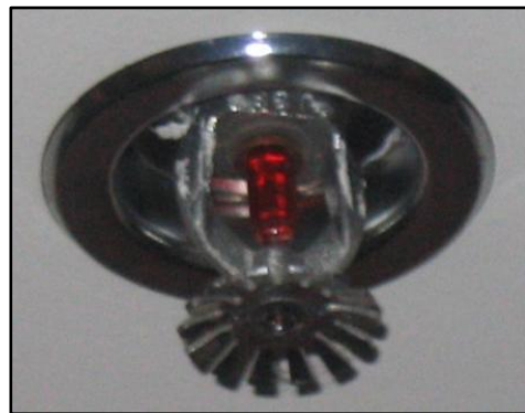
Figure 157 : Extincteurs automatiques (Source : Analyse de risque incendie)
