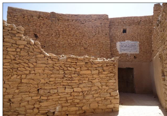
Figure III.7 : impasse de ksar Ain Madhi source : auteures
