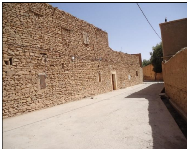
Figure III.12: façade aveugle source : auteures
