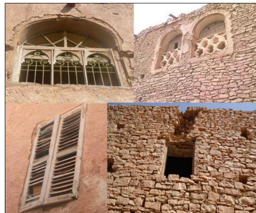
Figure III.23: les types des fenêtres de ksar source : auteures
