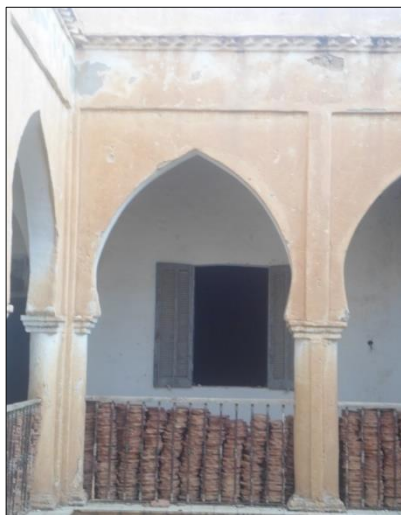
Figure III.17: les arcades de zaouïa source : auteurs
