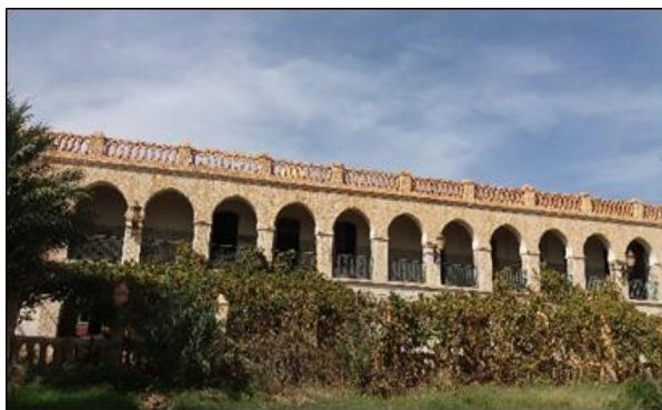
Figure III.29 : le bâtisse "palais Kourdane" source : auteures
