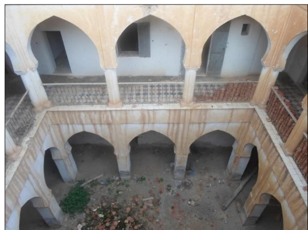
Figure III.19: vue d'intérieur de la zaouïa source : auteurs
