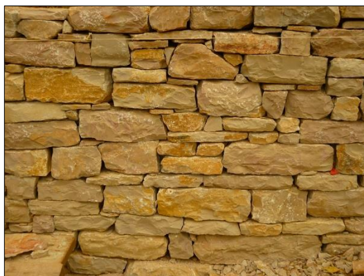
Figure II.7 : mur en pierre sèche source : https://pierressauvages.book.fr
