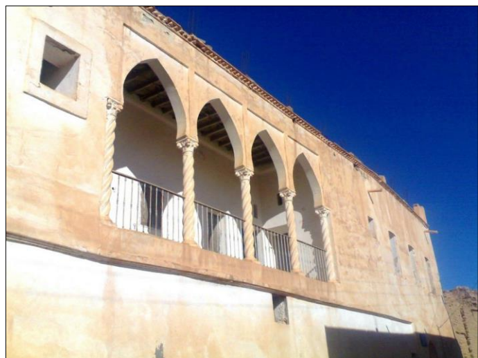
Figure III.18: façade de zaouïa source : auteurs
