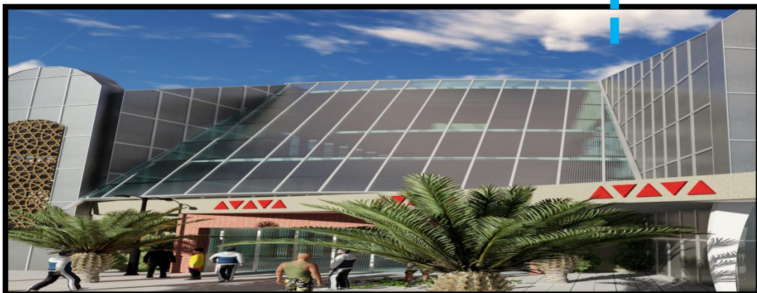
Figure.III.44 : vue sur l'entrée principale, source : auteur
