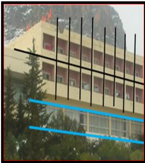
Figure. I. 21 : Façade principale de l'établissement thermal source : auteur.
