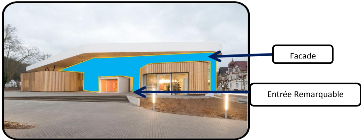
Figure .IV.11: façade principale, source : auteur.
