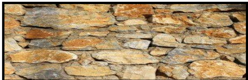
Figure.V.9 : Mur en pierre, source :internet
