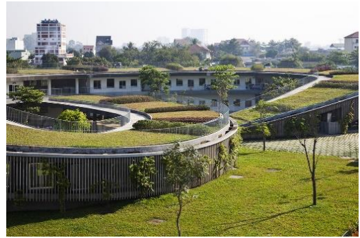
Figure 38 : Vue de la façade intérieure et extérieure Source : archidaily.com
