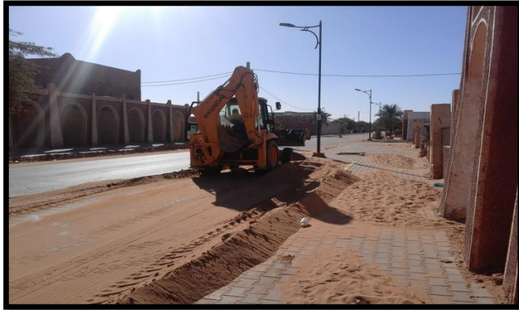
Fig.4.27. Le processus d'élimination du sable de la route par les autorités municipales à l'aide de machines.
