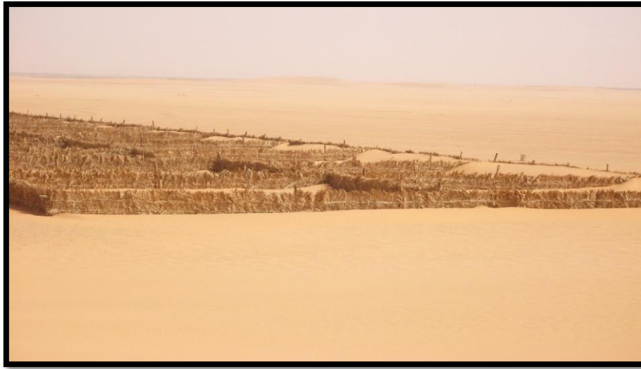
Fig.4.25. La technique des carrés utilisée dans le nord-est de la ville d'Ain Saleh.
