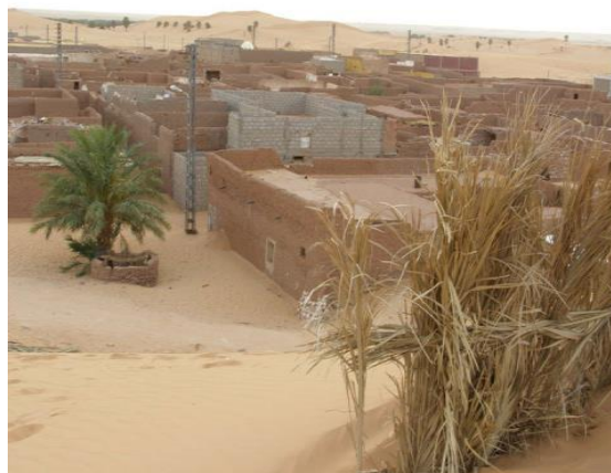
Fig.4.23. Exemple de lutte contre l'ensablement par Feuilles de palmier.
