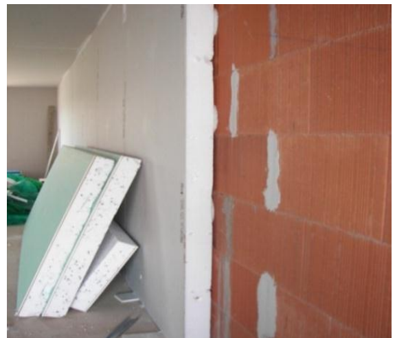
Figure 1. 17: Plaques de plâtre avec isolant polystyrènes [32].
