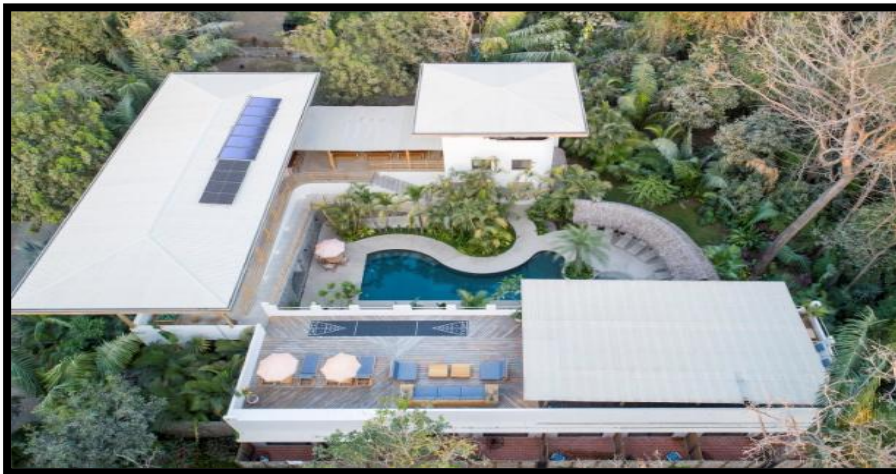
Figure 13 : vue générale de l'hôtel nomadique Source : www.archidaily.com
