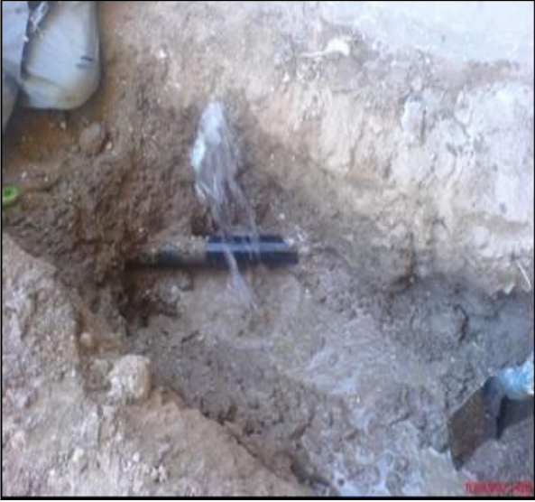
الشكل 3-5: تسرب مياه الصرف الصحي من خلال الأنابيب المتشققة.
