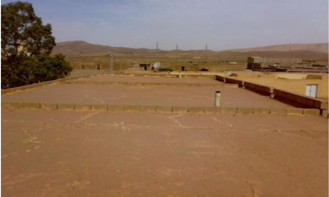
الشكل 3-11: تفتت الأسطح العازلة
