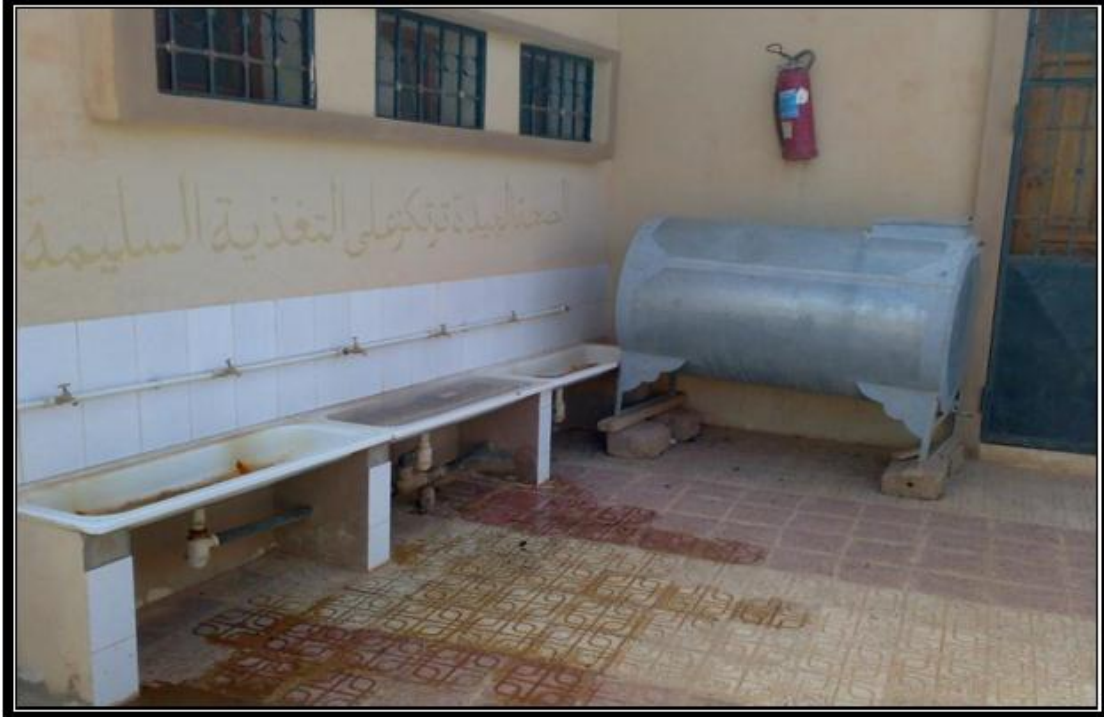
الشكل 3-10: تسرب المياه.
