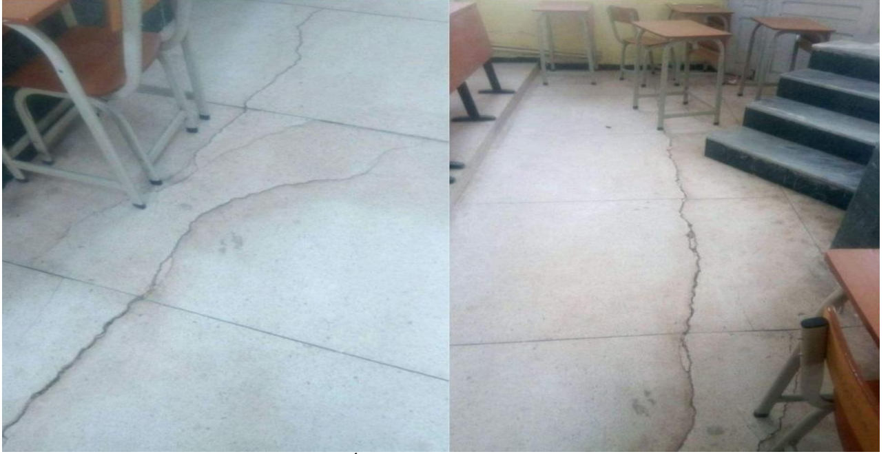
الشكل 3-16: تشققات أرضية
