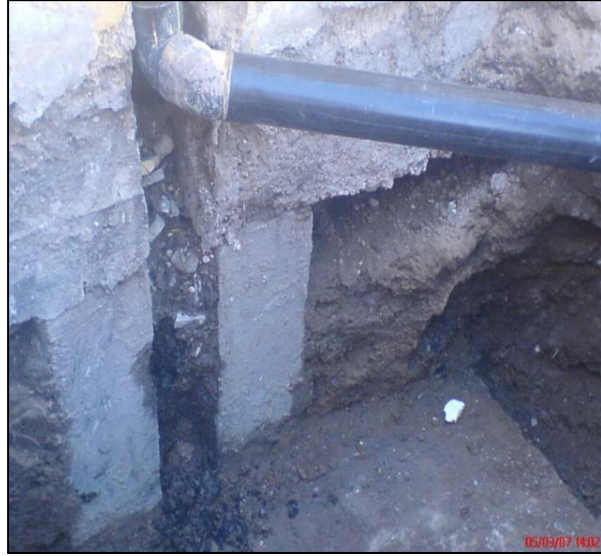
الشكل 3-5: تسرب مياه الصرف الصحي من خلال الأنابيب المتشققة.
