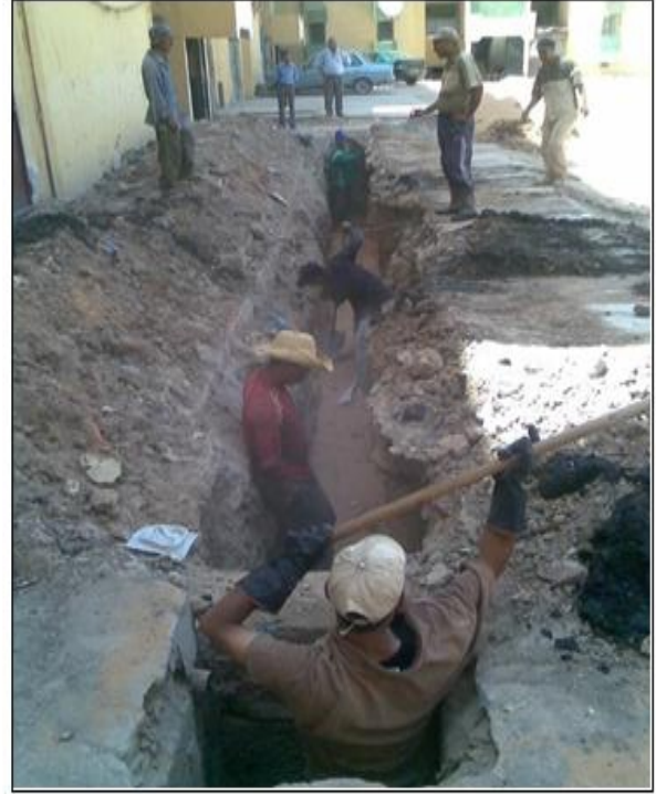
الشكل 3-6: تم نقل مجاري غرف التفتيش الرئيسية بالكامل خارج المبنى
