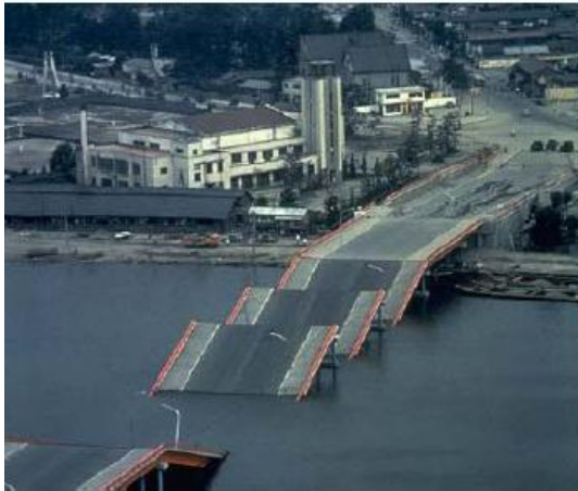
Effondrement des tabliers
