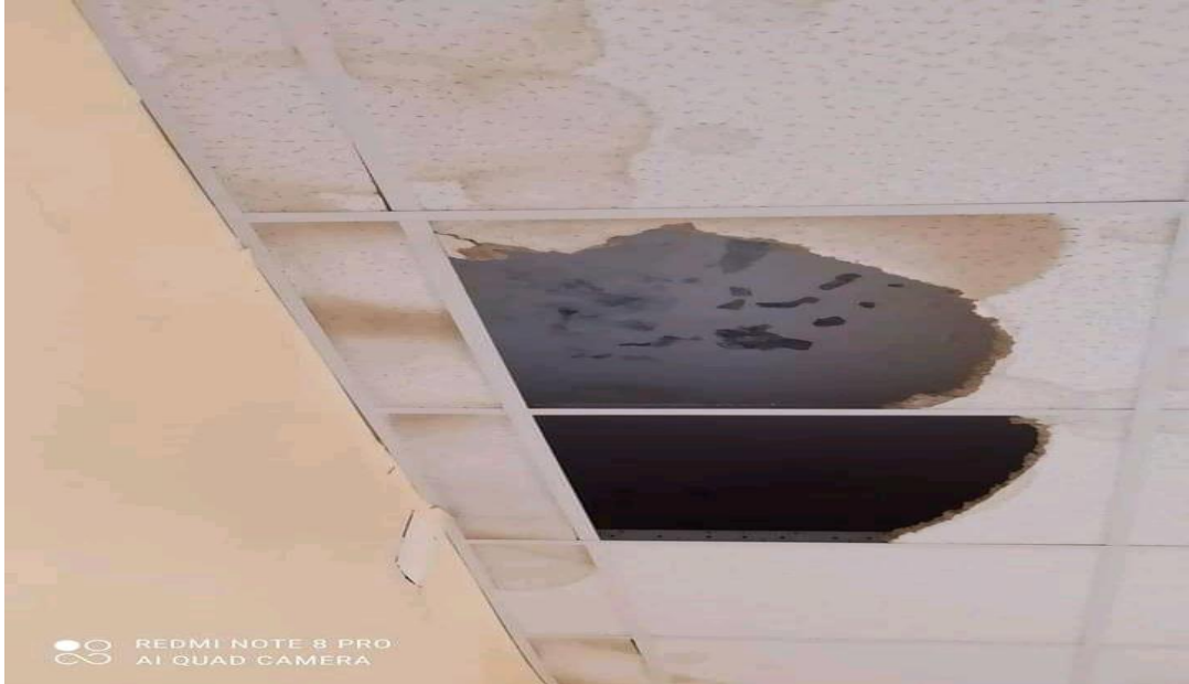
الشكل 3-17: اسقف قسم الهندسة الكهربائية
