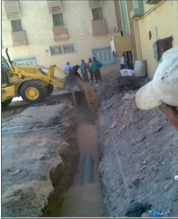
الشكل 3-6: تم نقل مجاري غرف التفتيش الرئيسية بالكامل خارج المبنى
