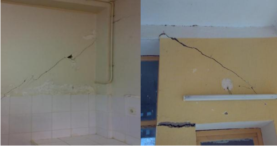
الشكل ب: شقوق مائلة عند 45^\circ درجة (مقصف)
