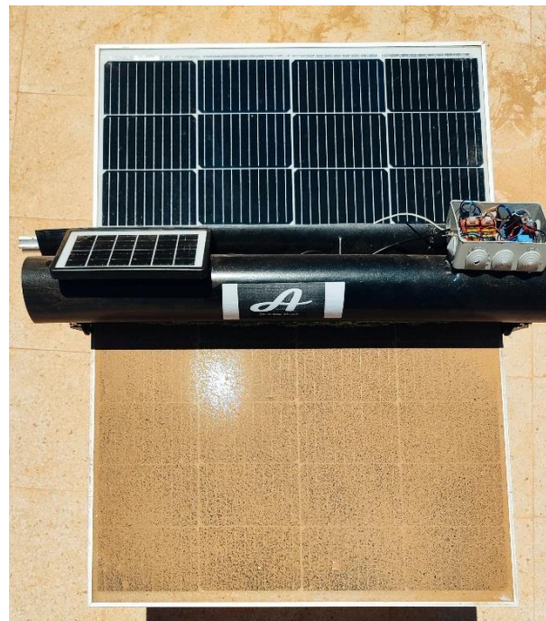
Figure III.19 Panneau solaire après nettoyage – La moitié du panneau a été nettoyée par le robot.
