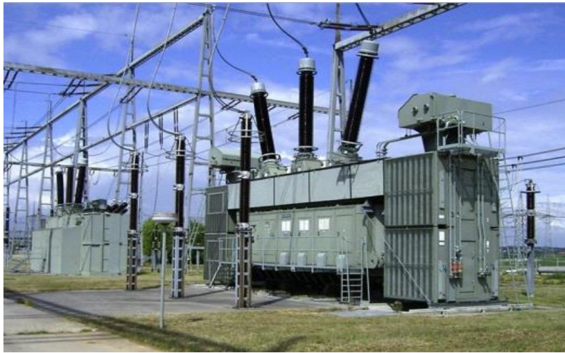
Fig. I.1. Un transformateur de puissance [4].
