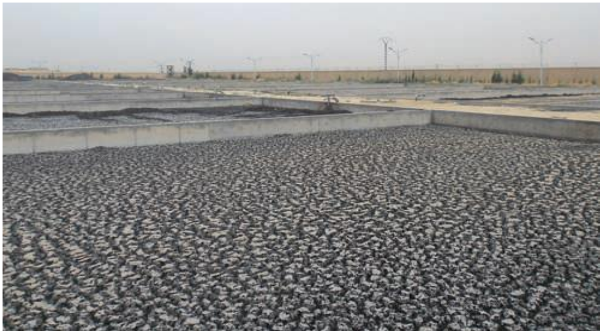
Figure 40 : Lit de Séchage non planté STEP de Laghouat .
