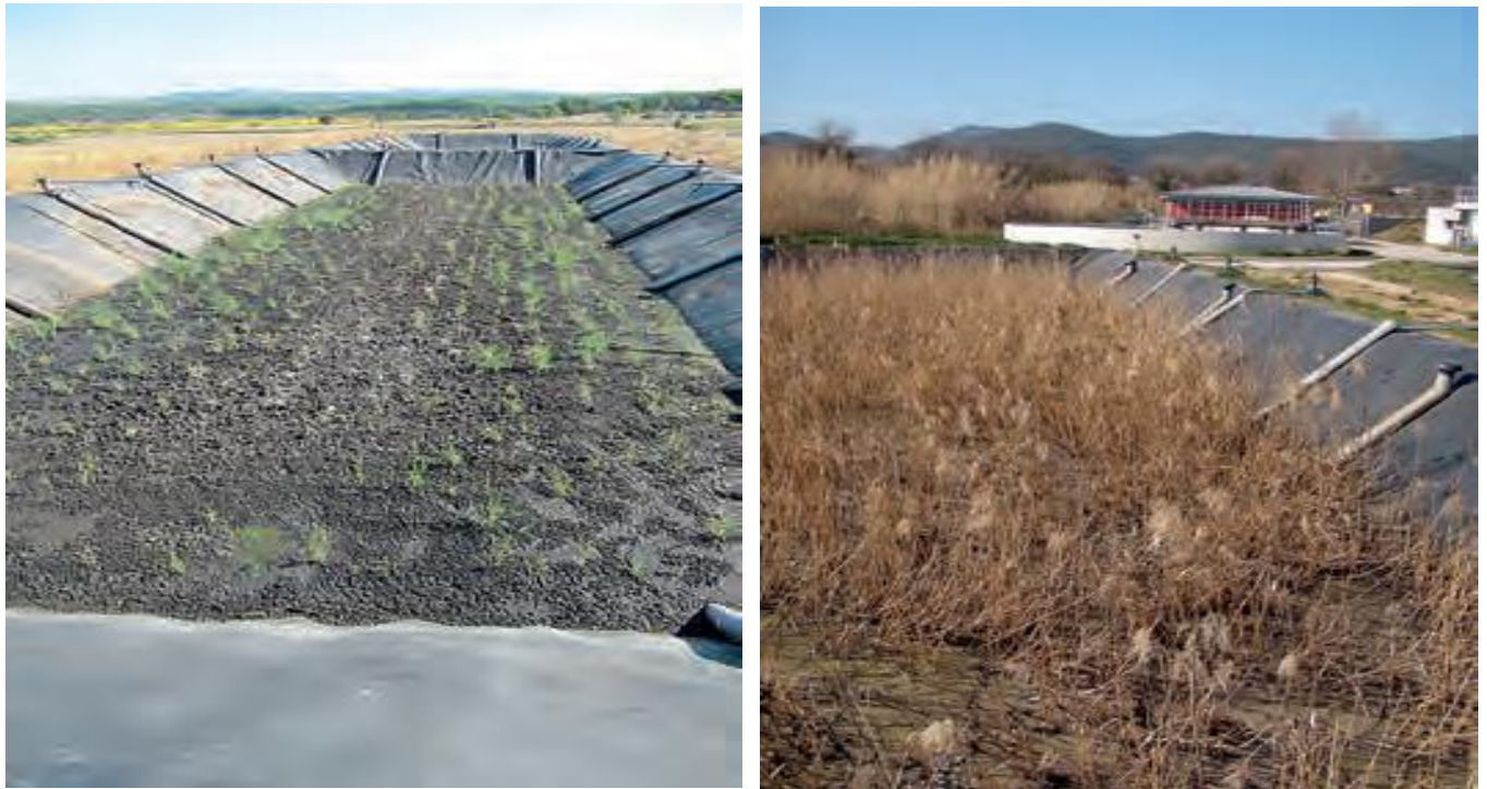
Figure 22 : LSPR Réalisés en Déblai/remblai
