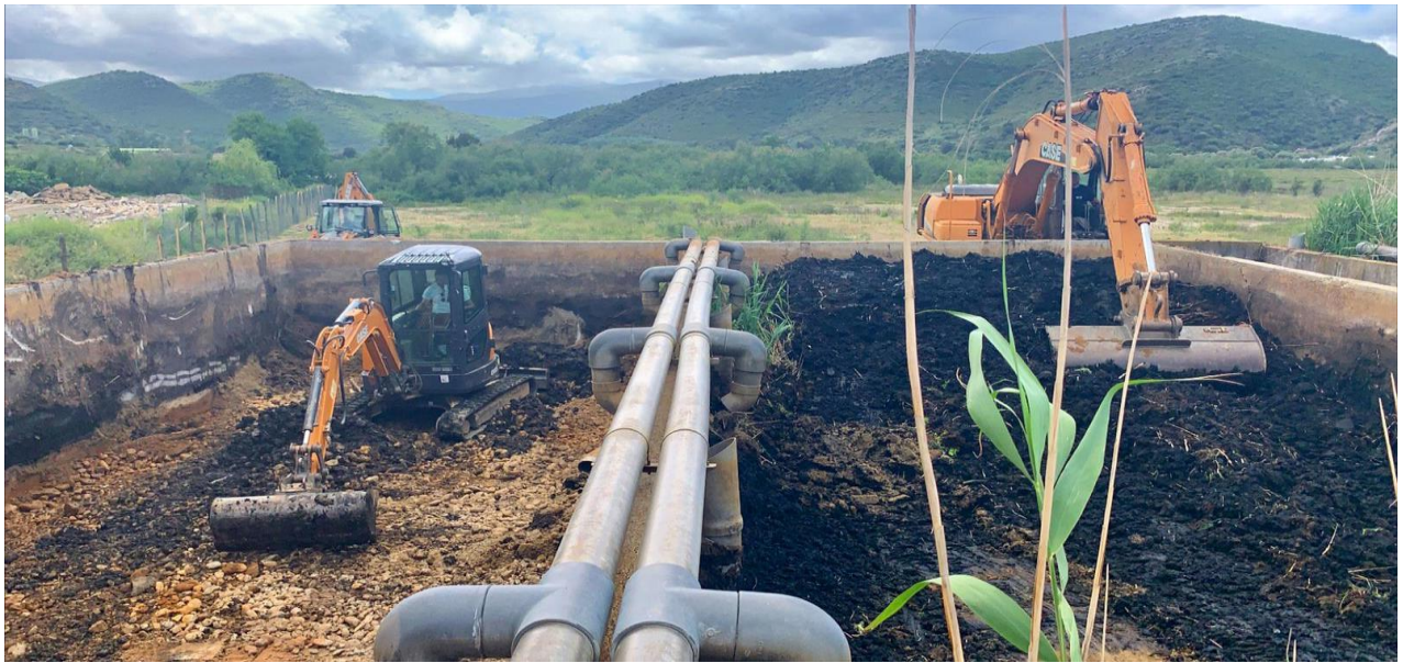
Figure 25: curage le lit de séchage par Roseaux
