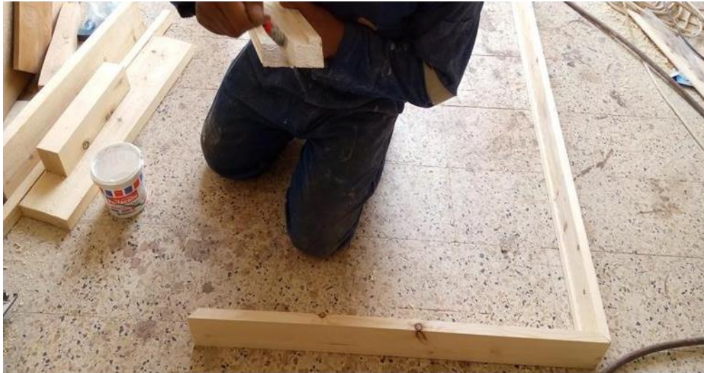
Figure 2.6 : Montage du cadre inférieur du panneau solaire.
