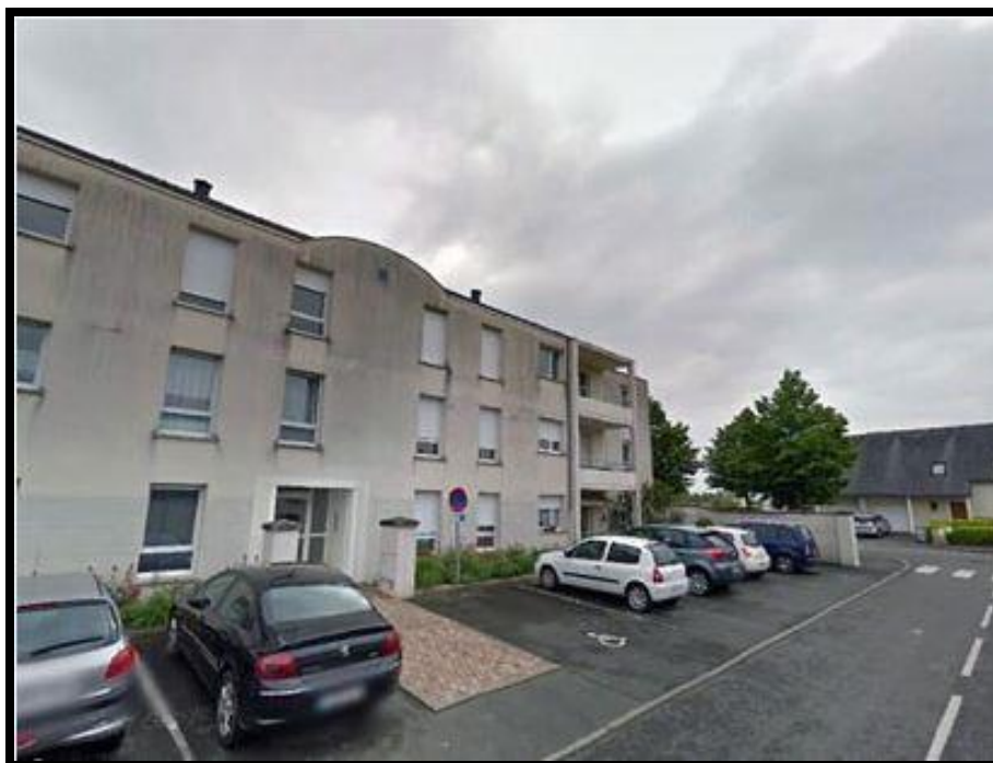
Figure 29:espace de stationnement au cœur de l'habitat collectif Renne France
