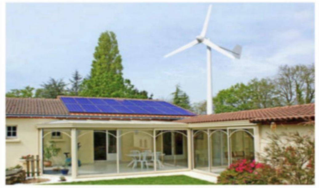
Figure 3 - Une éolienne domestique pour votre maison.
