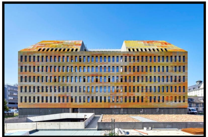
Figure 20: La façade du centre. Source: Groupe-6
