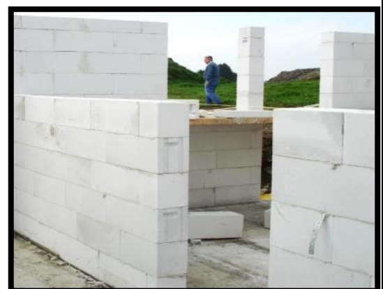
Figure 12 : Mur en maçonnerie. Source: isolation thermique.org
